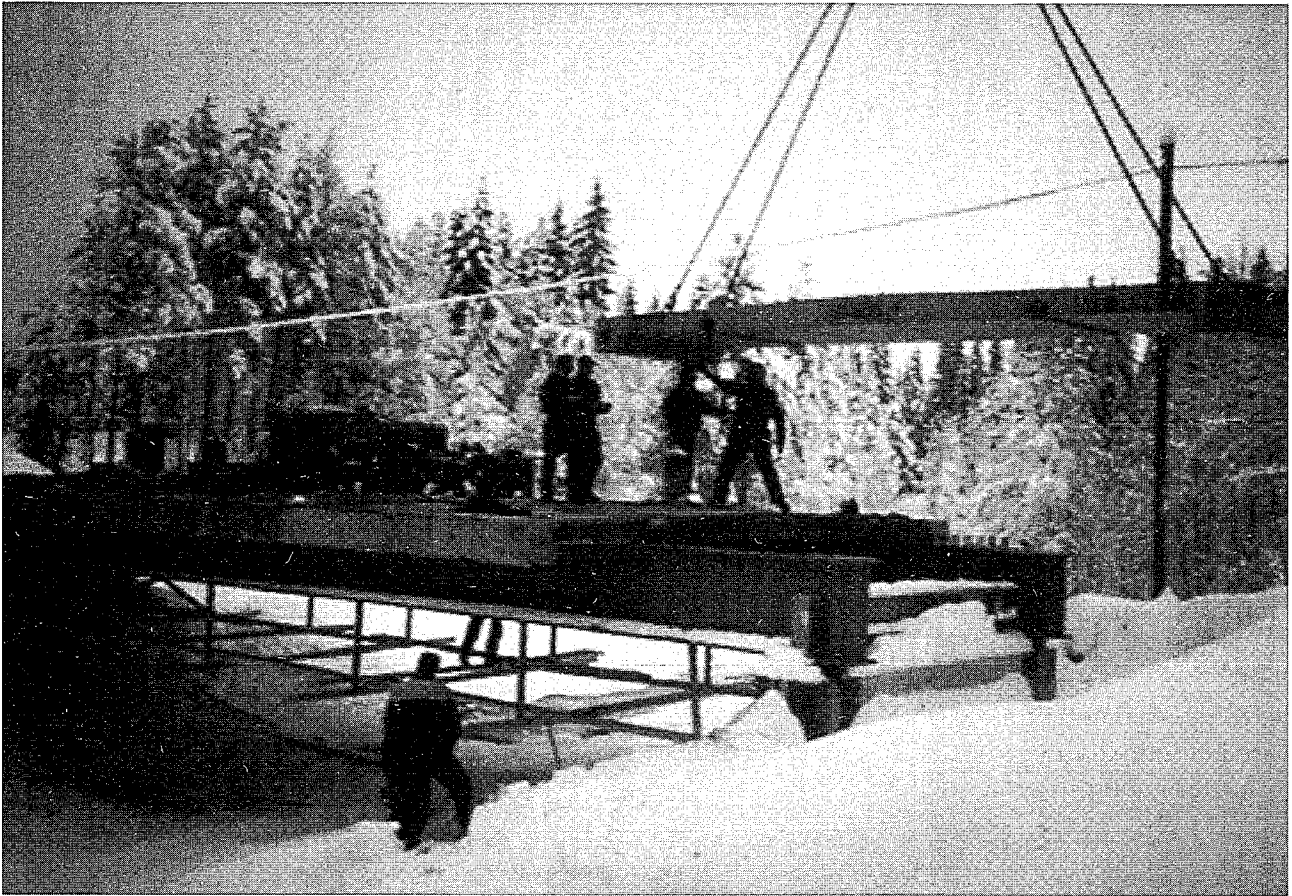
Montering av farbanelement till bro över Edslan.
